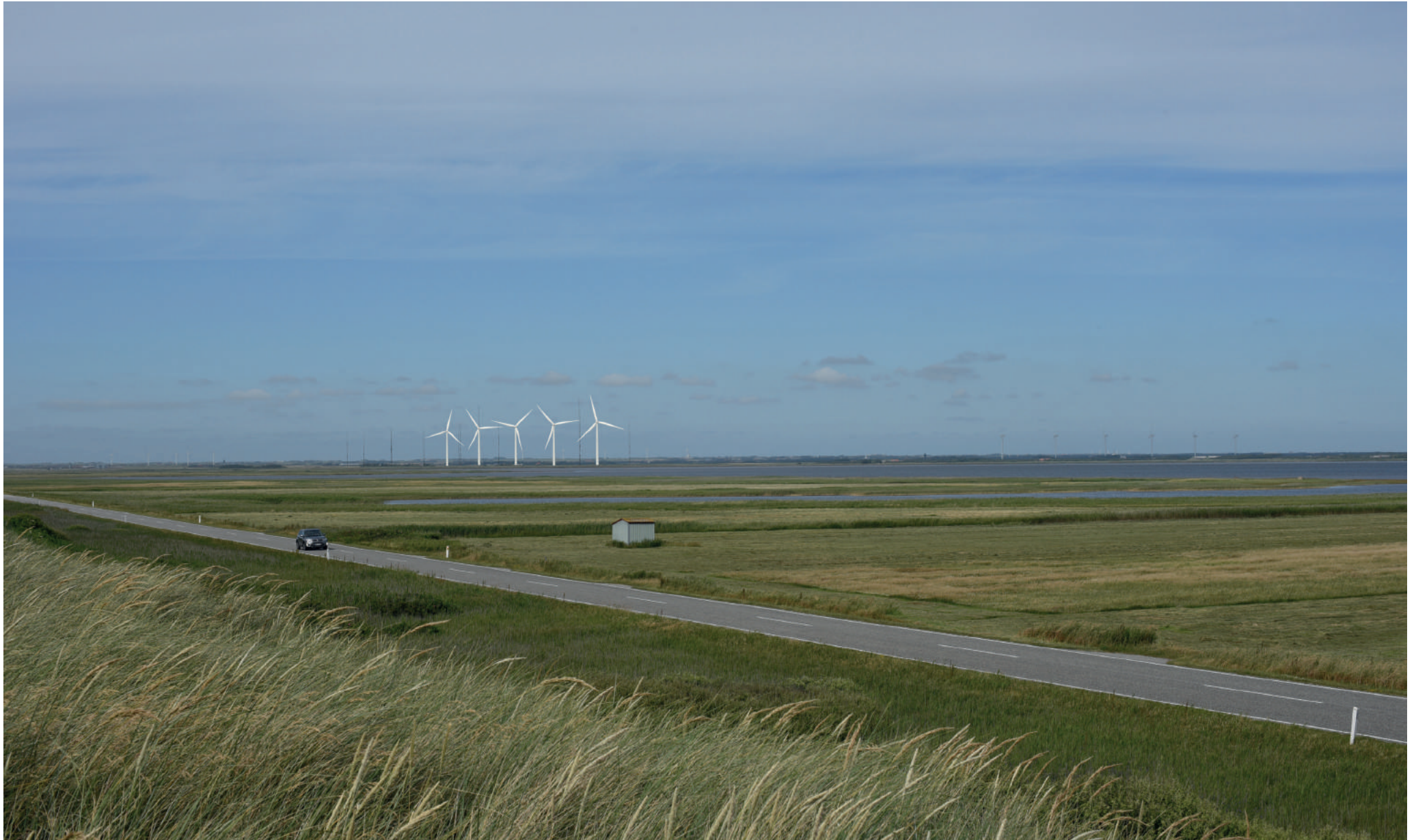
N-09: Bøvling Klit - eksisterende rummelighed: Maksimal totalhøjde 165 meter. Afstanden til nærmeste eksisterende prototypevindmølle er ca. 4,6 km. Betragtningsafstand 40 cm (A4).
