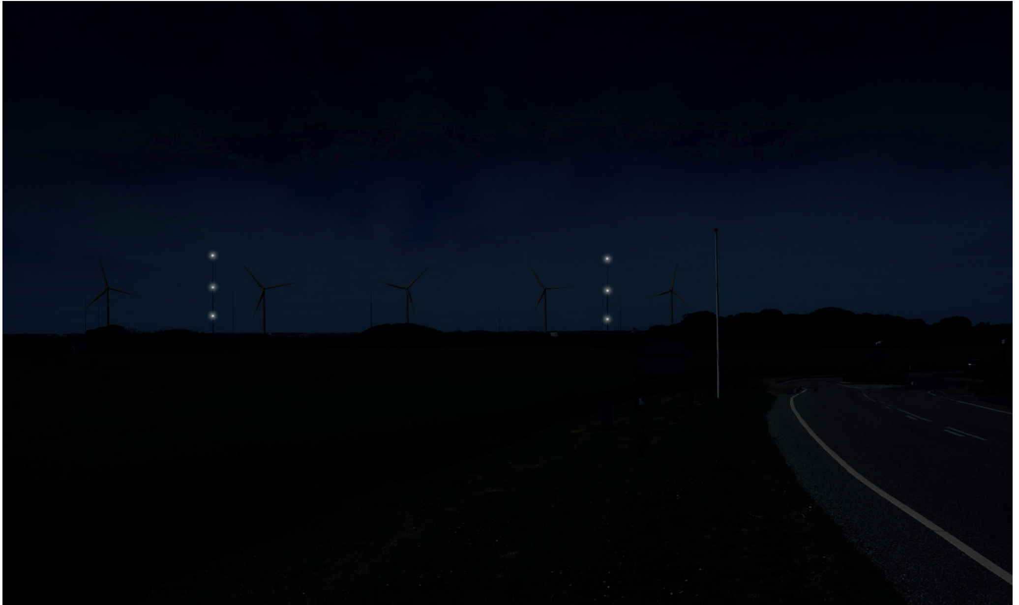
N-07: Bøvlingbjerg, Natvisualisering, eksisterende rummelighed - lysmaster 165 meter høje, højintensivt, hvidt blinkende lys. Afstanden til nærmeste eksisterende prototypevindmølle er ca. 2,9 km. Betragtningsafstand 40 cm (A4).
