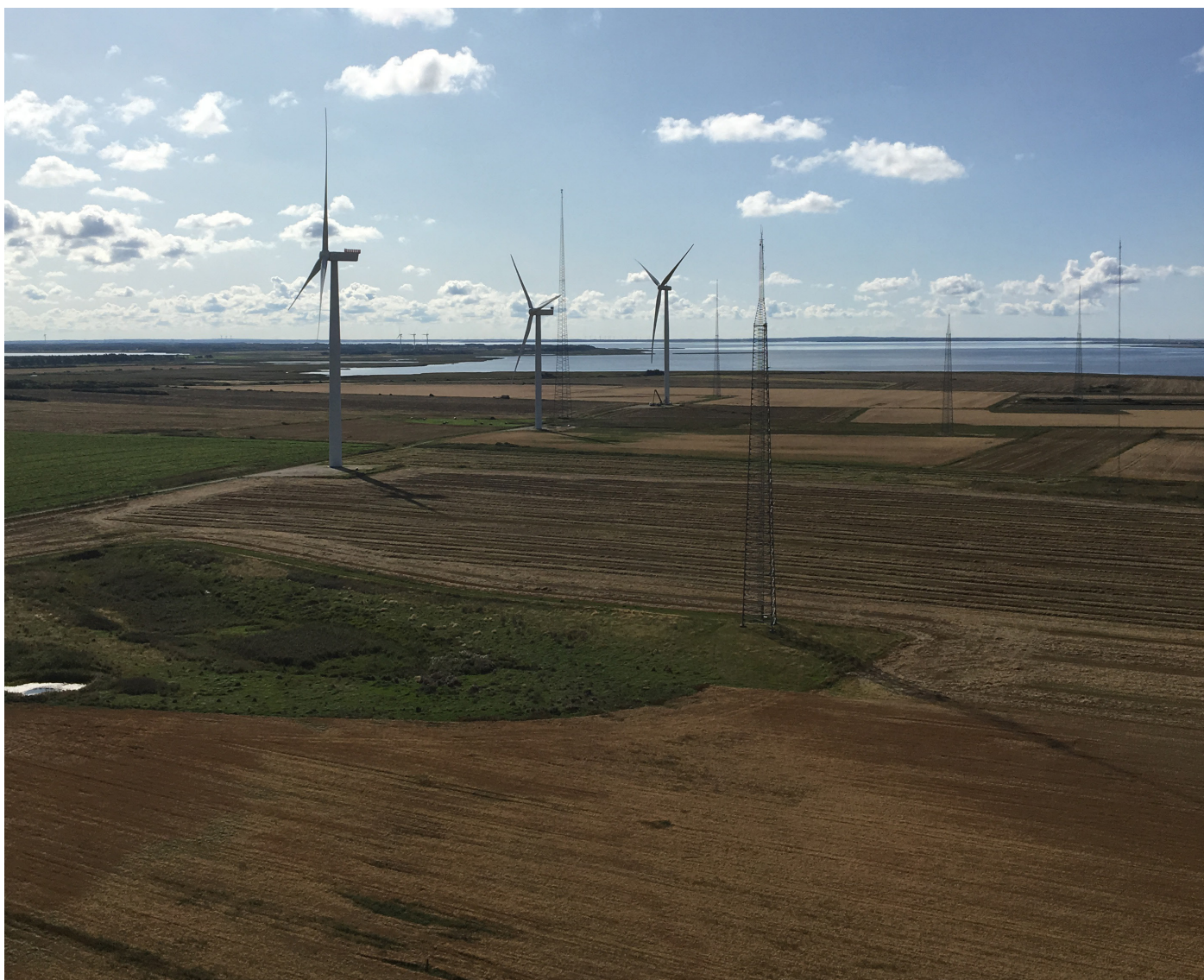
Høvsøre set fra lysmast
