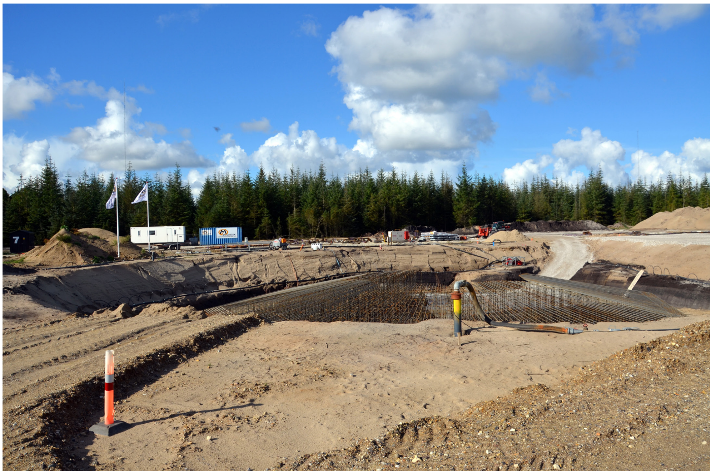
Etablering af fundament - eksempel fra Østerild Testcenter
