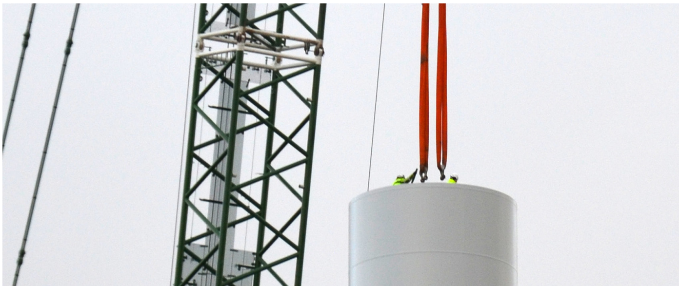
Montering af tårnsektion med kran
