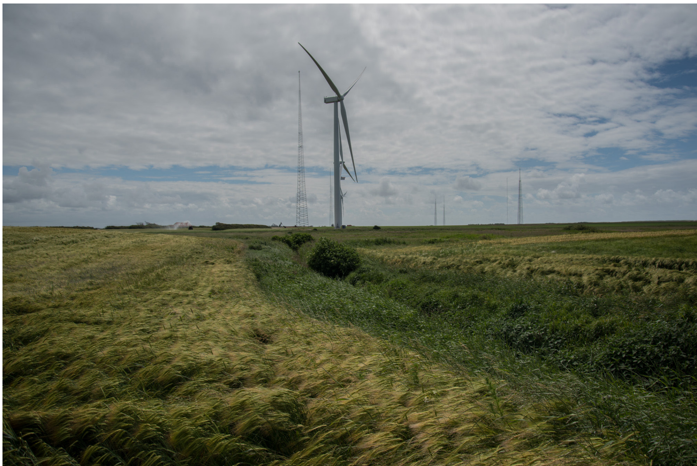
Figur 5.a - Placering 1 set fra nord i retning mod den nuværende prøvestation. Bemærk det åbne vandløb i forgrunden i området, som er foreslået til mølleplacering
